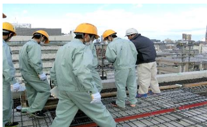
建設現場見学会
