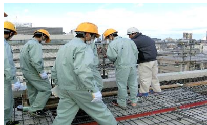
建設現場見学会
