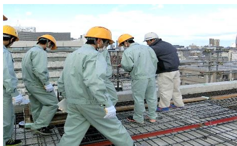
建設現場見学会
