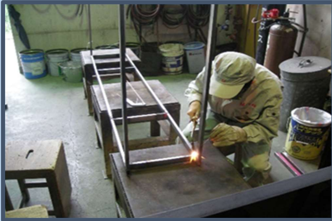
バックパネル運搬車製作
