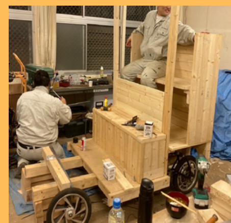
④タイヤの取り付け 後ろ椅子の作成
