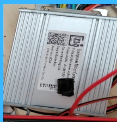
②モーターコントローラ に配線を行う
