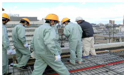
建設現場見学会
